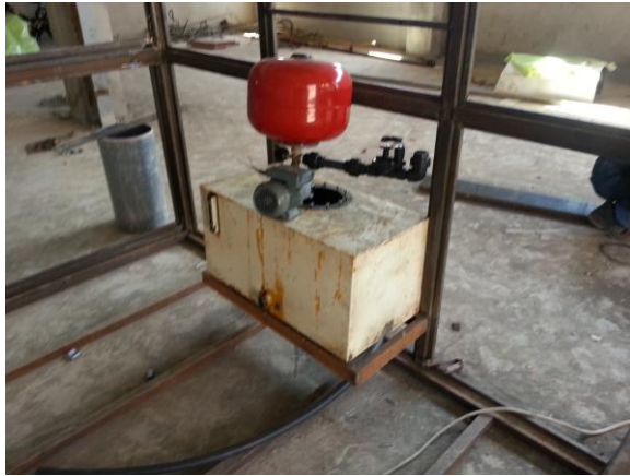
Soudage du réservoir au châssis de la serre et fixation du moteur.
