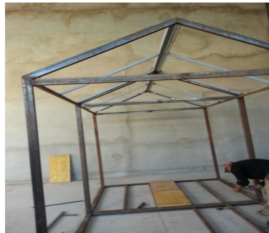
Montage des ouvrants.
