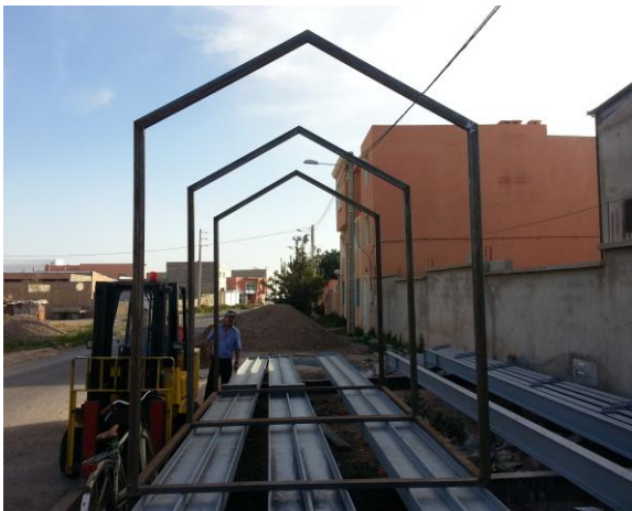
Soudage des armatures.
